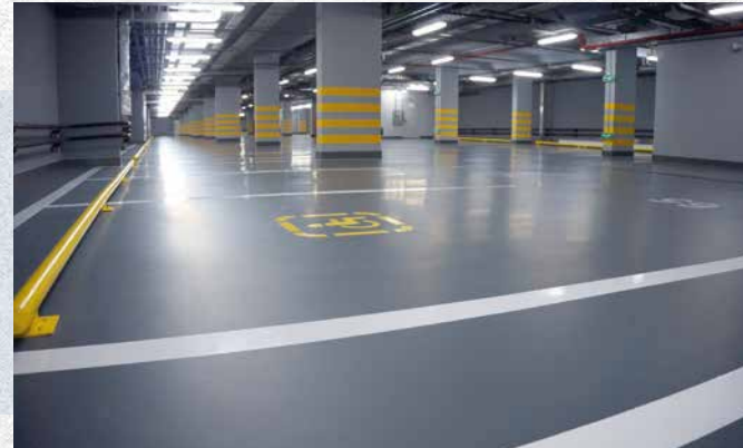
ЖК Кленовый дом, Москва, MasterTop 1324
