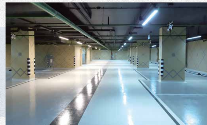
Паркинг ЖК Реномэ Москва, MasterTop 1324R/1324 Ramp
