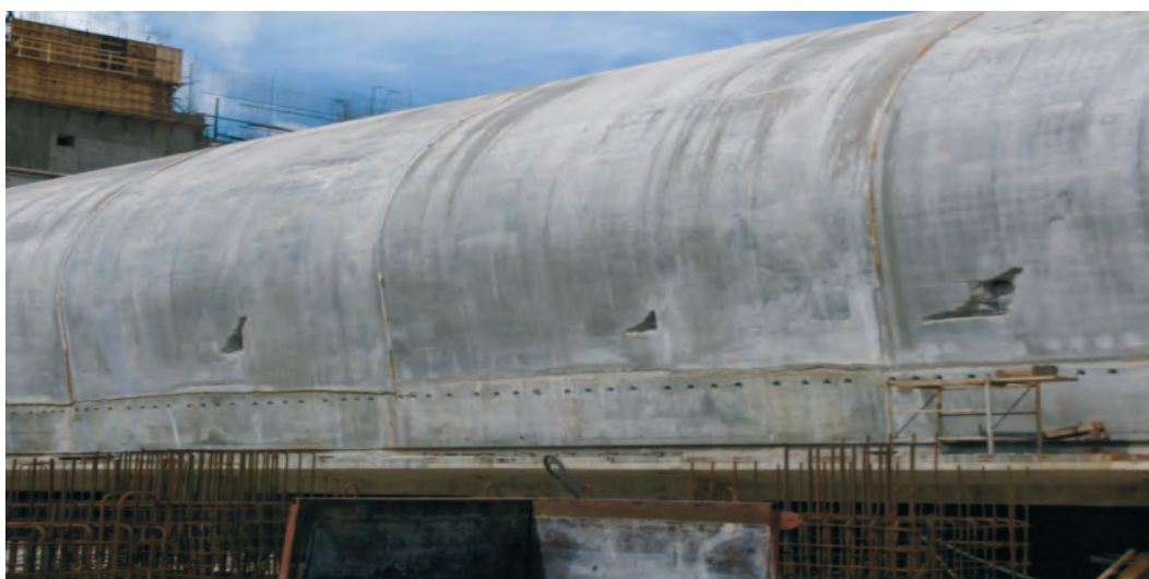
Рисунок 6.8 – Напорные водоводы гидроаккумулирующей станции: а – панорама строительства трубопроводов; б – дефектные участки бетона на поверхности трубопровода
