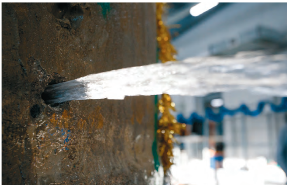
Рисунок 7.2.34 – Напорная течь
