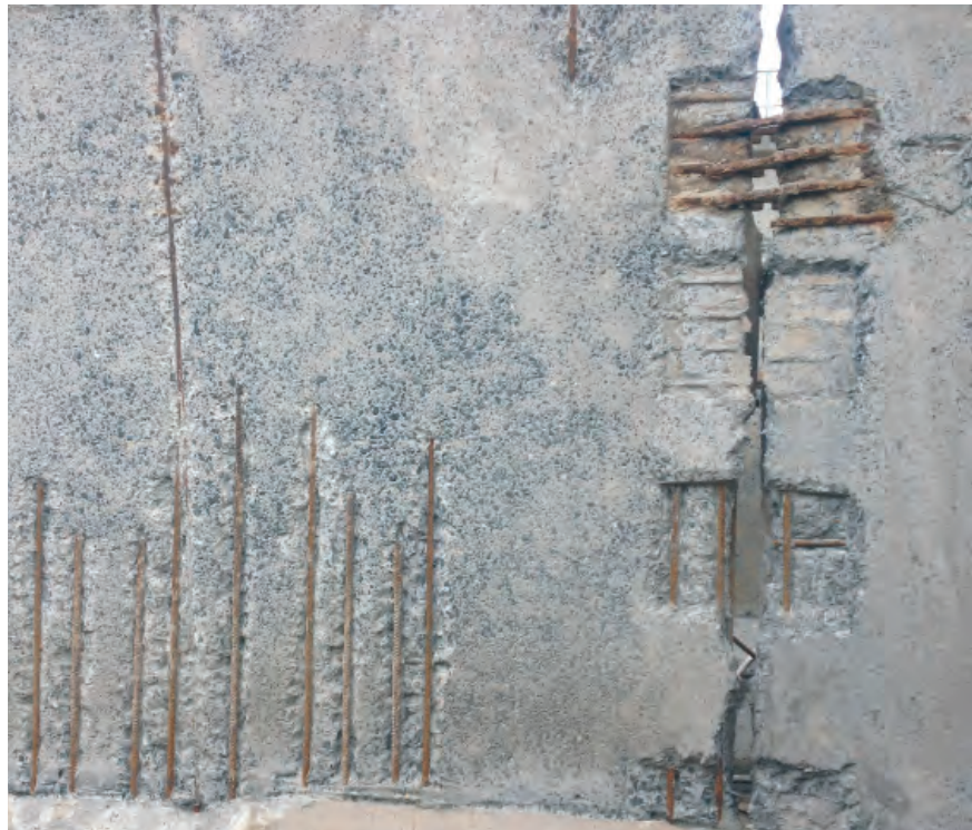
Рисунок 7.4.3 – Удаление структурно непрочного бетона и бетона вокруг арматурных стержней
