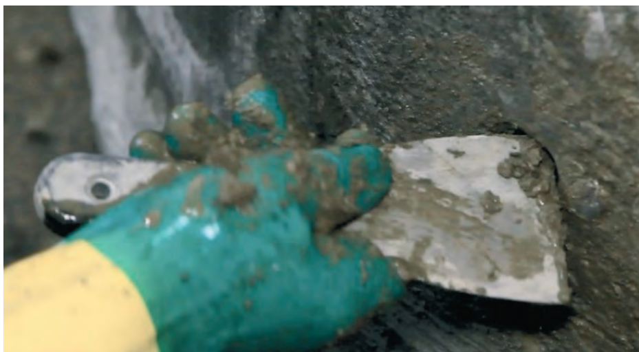
Рисунок 7.2.39 – Удаление остатков растворной смеси из полости течи
