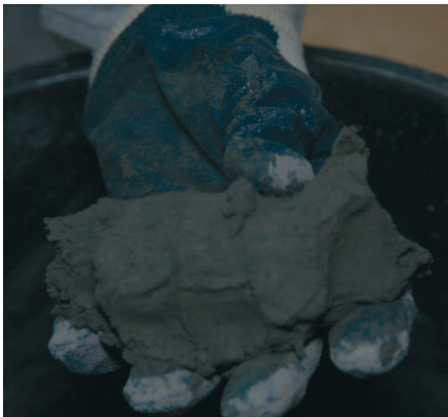
Рисунок 7.2.26 – Приготовление растворной смеси «Пенекрит»
