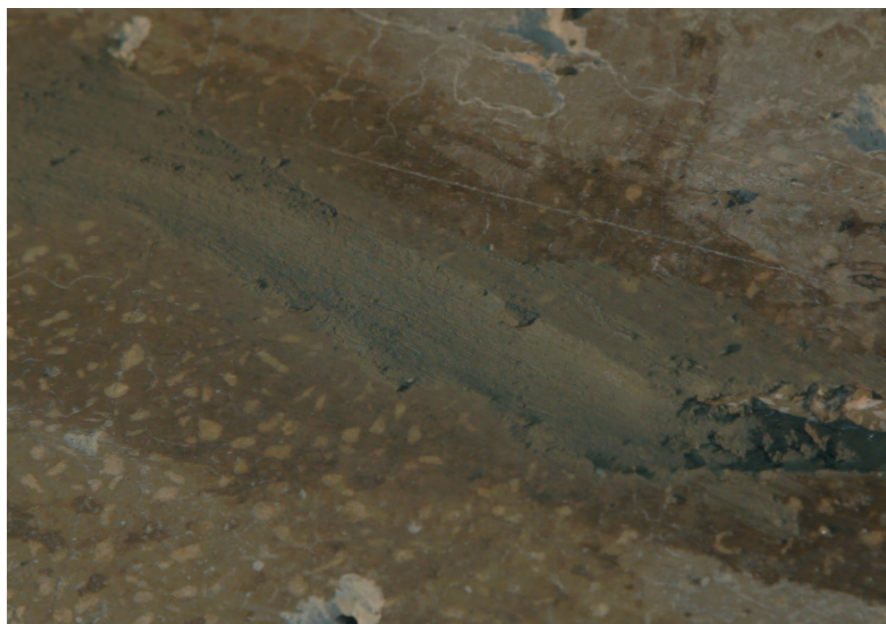
Рисунок 7.2.27 – Штраба, заполненная растворной смесью «Пенекрит» и обработанная растворной смесью «Пенетрон»
