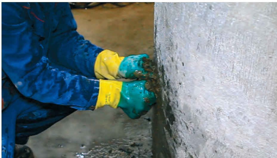
Рисунок 7.2.38 – Удержание растворной смеси в полости течи
