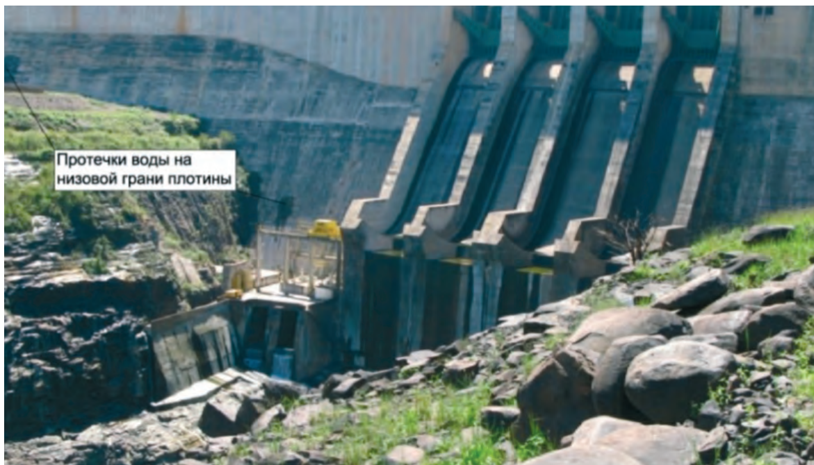
Рисунок 6.2.3 – Плотина из укатанного бетона
